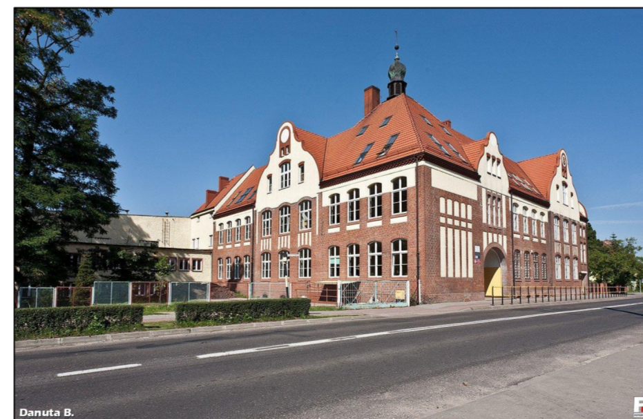
WIDOK BUDYNKU - STRONA FRONTOWA
