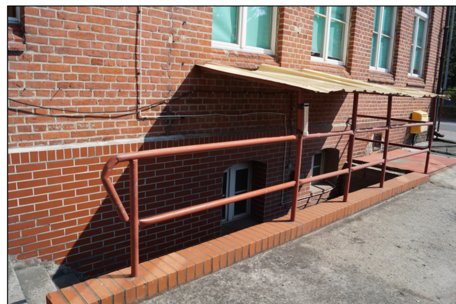
WIDOK WEJŚCIA DO KOTŁOWNI
